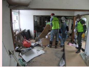
→ 家屋の床下に入り込んだ泥上げ ↓ 家屋内の瓦礫撤去 ✓ 瓦礫撤去が進んだ状態。細かな瓦礫も箒で撤去する
