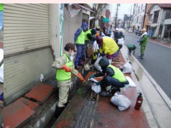
← 瓦礫や泥が詰まり水が流れない側溝 ↑ 側溝の泥上げ作業 ← 水が流れるようになった泥上げ後の側溝
